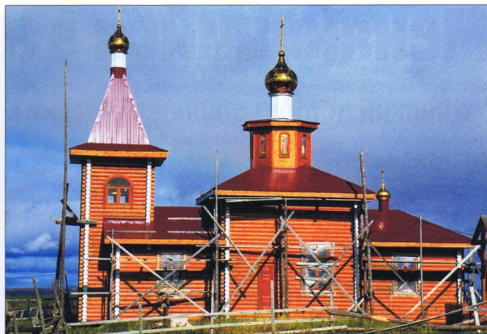
Строящийся храм в селе Нерица.
